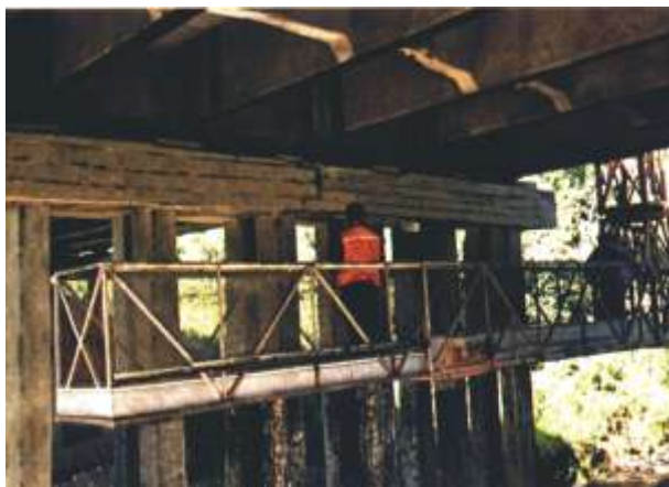
Puc. 1. Nosníky mostu přes řeku Kechtu po opravě a zesílení (je vidět pásy z kompozitu).
